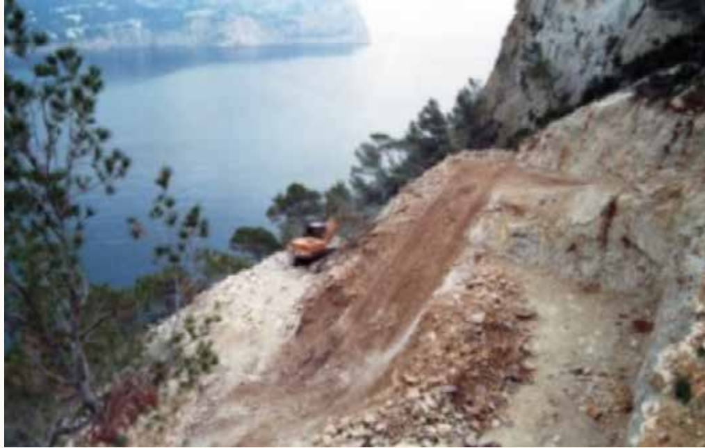
Obras Museo Liedtke Puerto de Andratx
